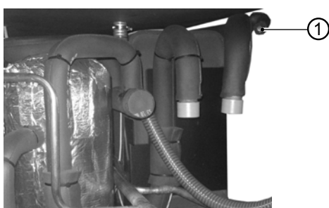
1 Odvzdušňovací ventil nad hydraulickými přípojkami v jednotce
